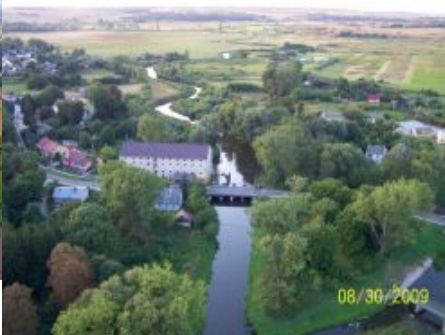
Młyn z elektrownią wodną w Tarnogórze
