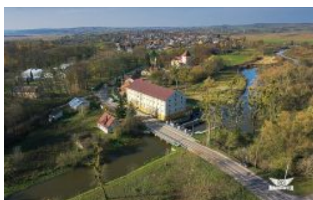
Młyn z elektrownią wodną w Tarnogórze
